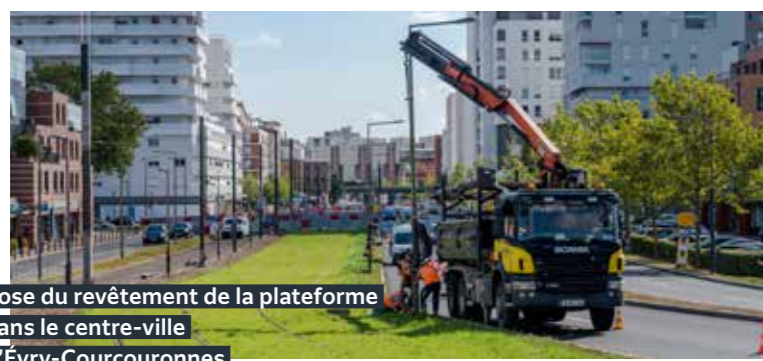
Construction du mur de soutènement entre Morsang-sur-Orge et Viry-Chatillon
