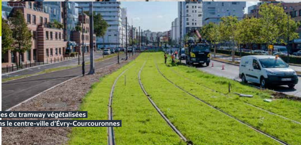
Pose des rails près du carrefour de la RD 445 à Viry-Chatillon
