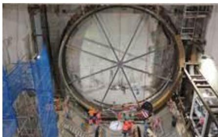
Courbevoie, 12 novembre 2018. La virole de démarrage, porte d'entrée du tunnelier pour creuser, à 30 mètres de profondeur,
